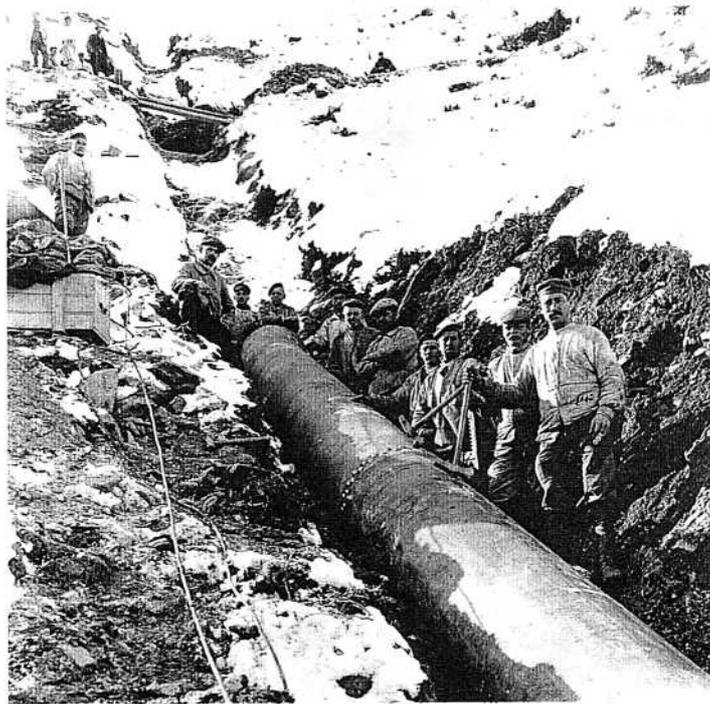
Fig 38 - Montage de conduite forcée aux Sept Laux - 1917
