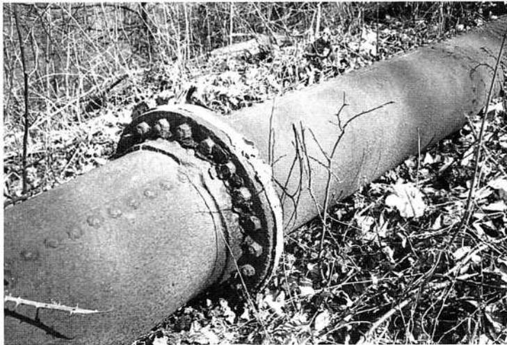
Fig 30 - Conduite forcée de la chute de 500 m de la Combe de Lancy - 1882
