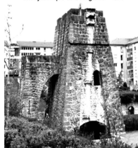
Fig. 5 : Pylône support des poulies du câble téléodynamique de Bellegarde, 1873
