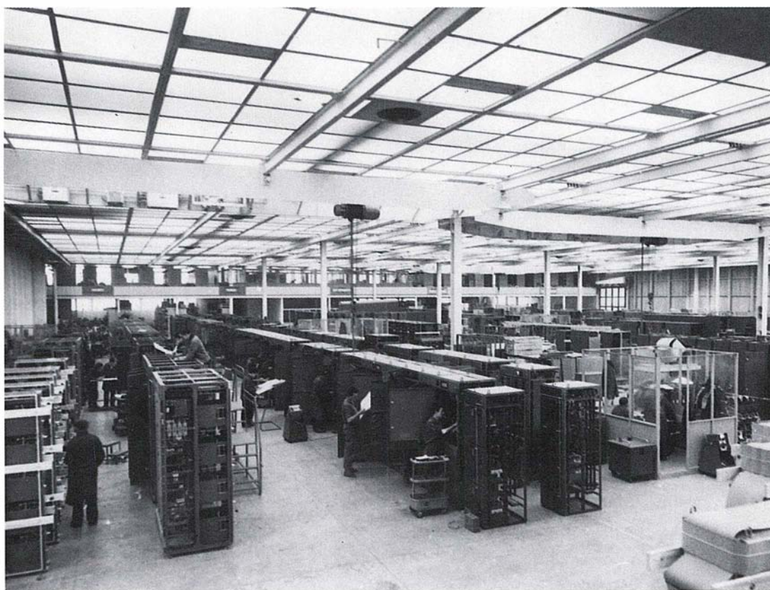
Atelier de montage des Préblocc à l'usine S : le passage à l'usine moderne.
