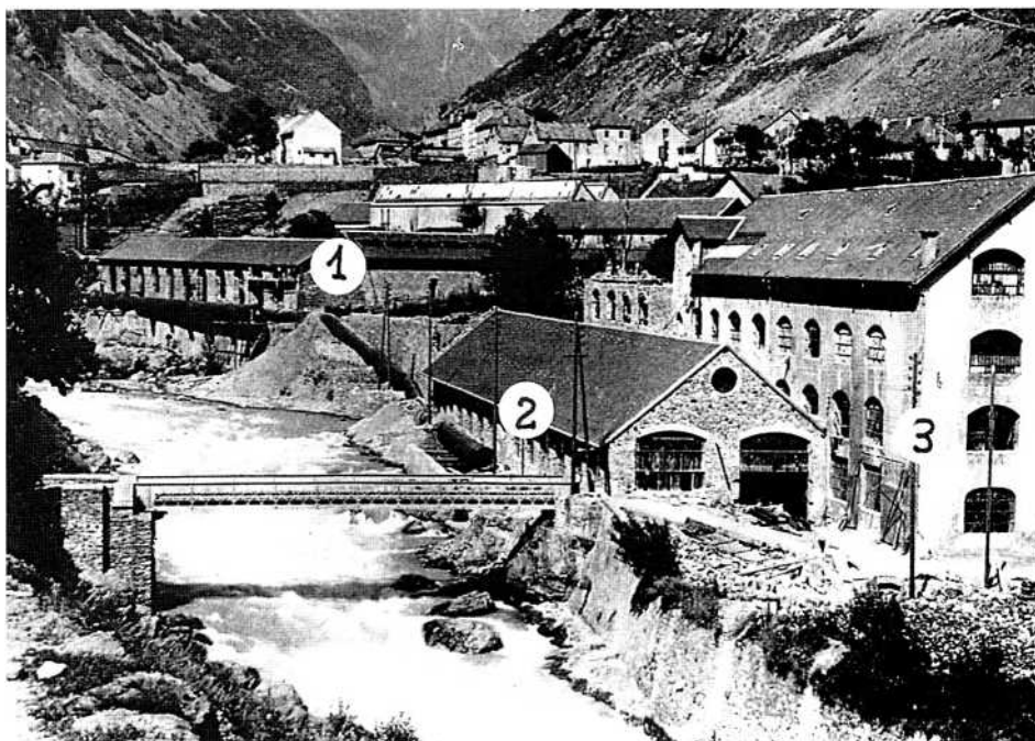
Fig. 65 - Pont de la Salinière vers 1908. Installation des conduites sur la rive de la Romanche : 1- Petite centrale avec fours à ferro-alliages - 1903 2- Station d'essais de turbines (1908) - démolie en 1954 3- Ancien bâtiment de papeterie démolie en 1993
