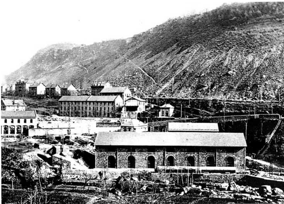
Fig. 67 - Après l'arrêt de la papeterie, démolition d'une partie des bâtiments
