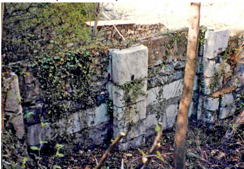
Fig. 54 - Glissières des deux vannes du canal élargi par Neyret en 1867
