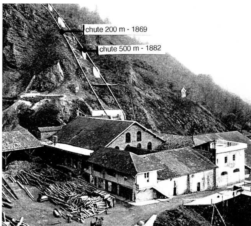
Fig 31 - Papeterie Bergès - 1883 Les deux conduites forcées de la Combe de Lancey
