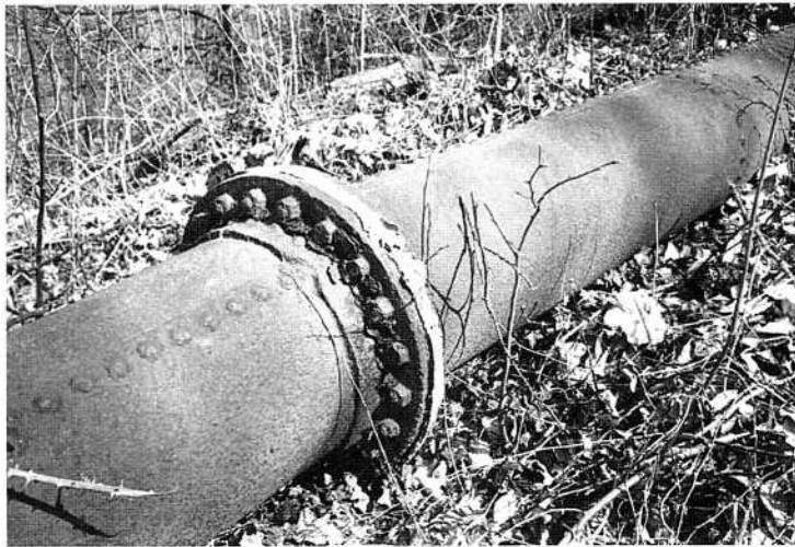
Fig 30 - Conduite forcée de la chute de 500 m de la Combe de Lancy - 1882
