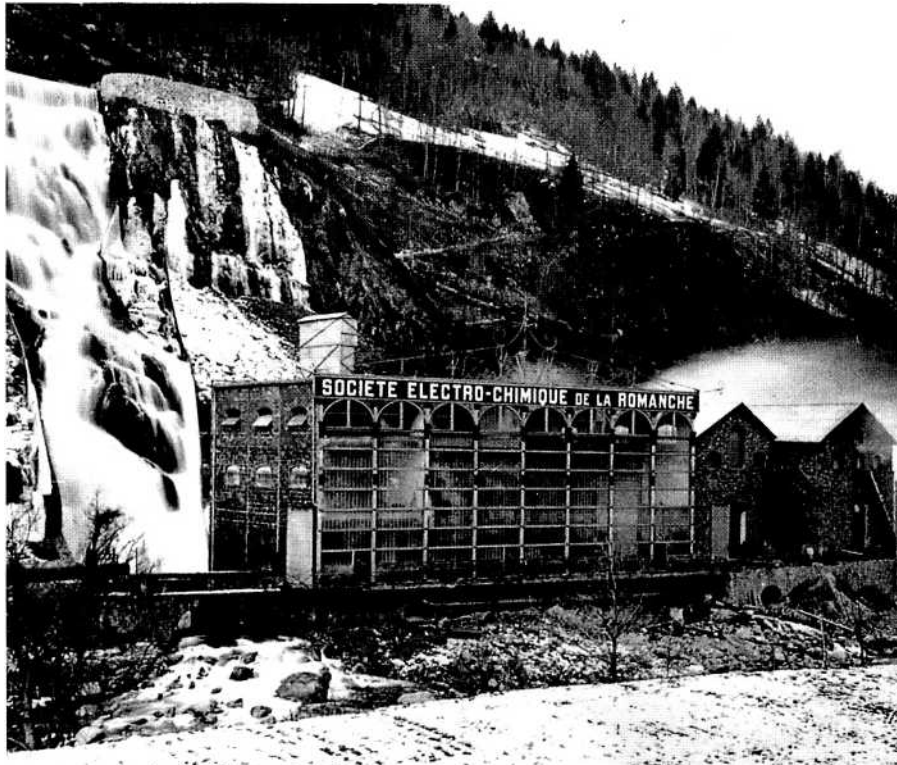
Fig. 45 - La centrale de Livet sur la Romanche pour l'éclairage de Grenoble - 1905
