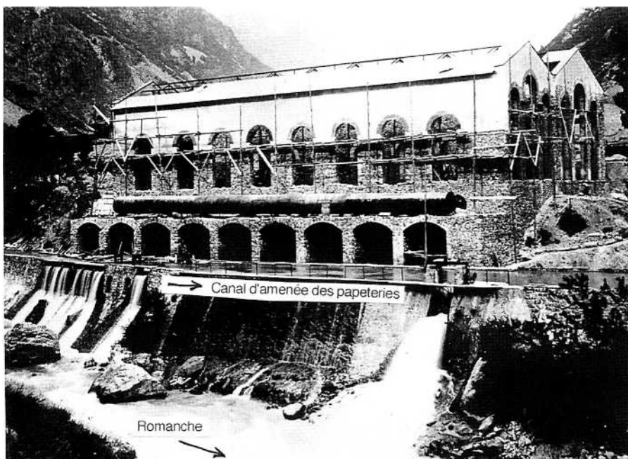
Fig. 64 - Équipement de la chute de 35 m (1898-1901) Situation en 1908 avec les quatre conduites forcées et le canal de la papeterie (chute de 25 m) maintenu.
