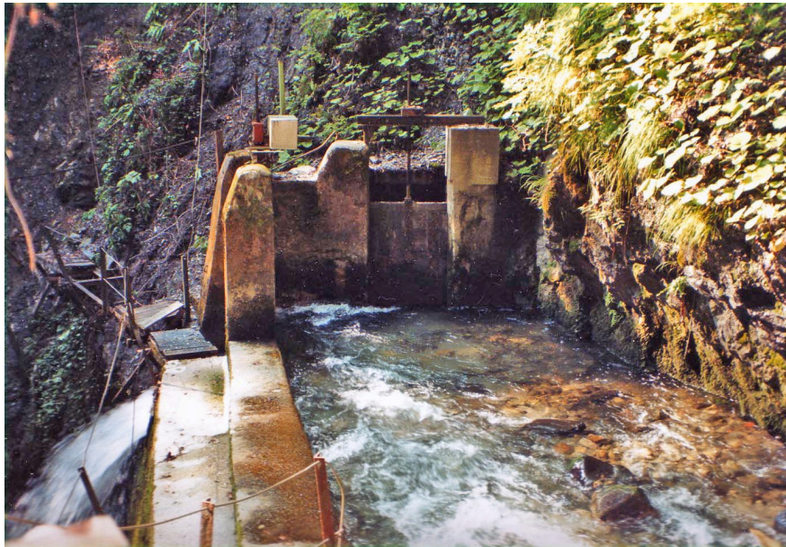
Fig 22 - Prise d'eau du canal de la centrale Frédet à Brignoud
