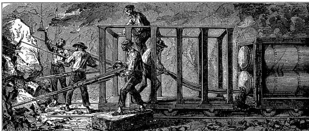
Fig. 8 - Les perforatrices à air comprimé au tunnel du Mont Cenis
