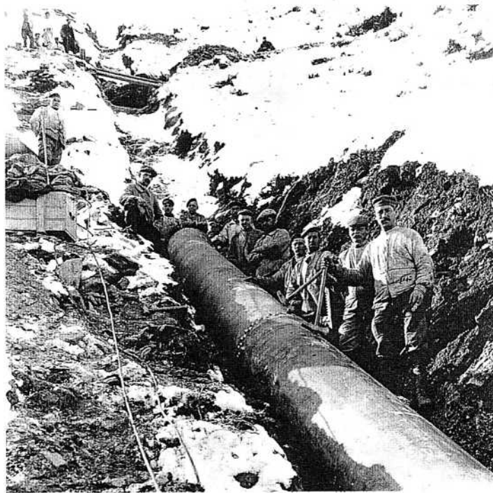
Fig 38 - Montage de conduite forcée aux Sept Laux - 1917
