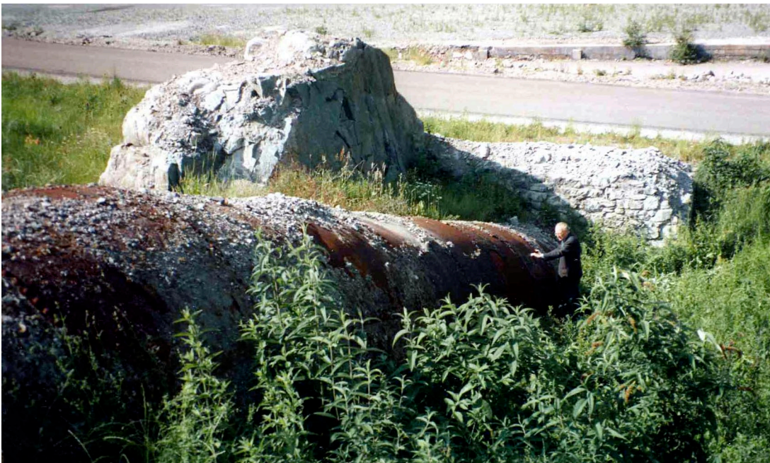
Fig. 59 - Ancienne conduite forcée 1869, remise à jour en 1993
